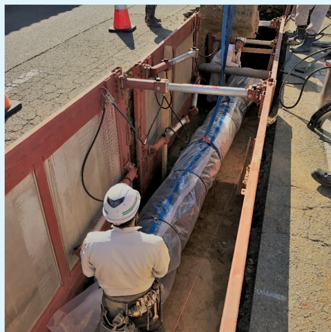
更新工事の様子(大沼町3丁目付近)
