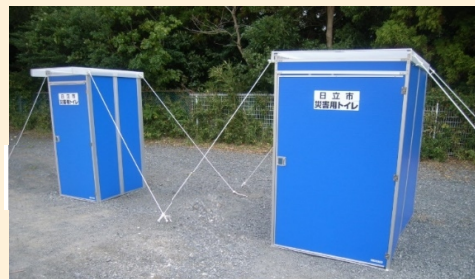
マンホールトイレ設置後
