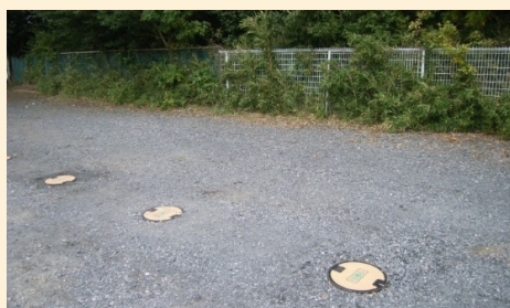
マンホールトイレ設置前
